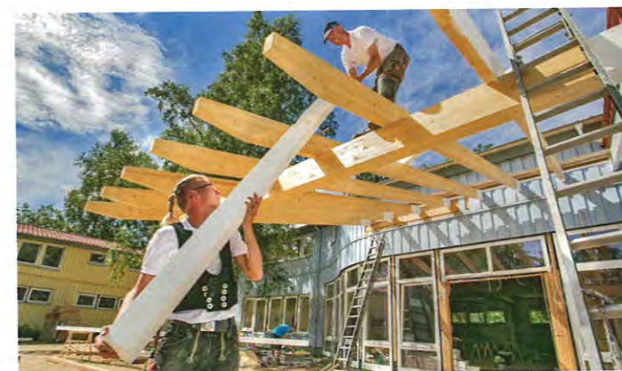
Das Bauteam vom Michaelshof Sammatz hat das ganze Jahr über Hochsaison. Hier beim Errichten eines Vordaches für das neue Gästehaus neben dem „Haus der Natur“
