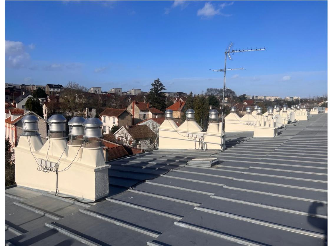
Projet de mise en place d'un système de ventilation basse pression Hygro A avec caisson sur conduit Schunt et traitement des logements
