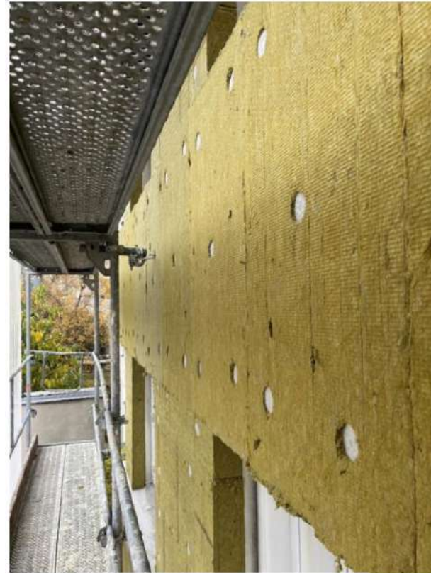
Mise en œuvre de l'isolant
