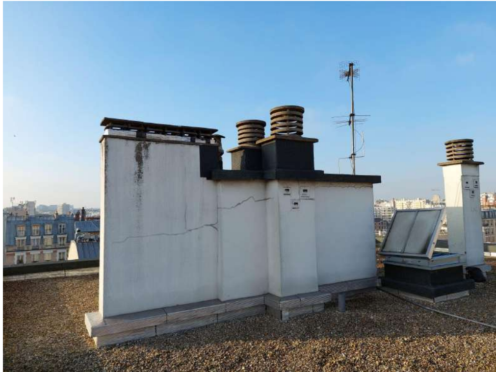
vue de la terrasse avant travaux
