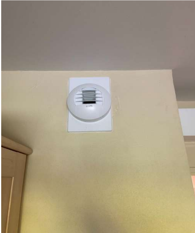
Installation de la bouche salle de bain
