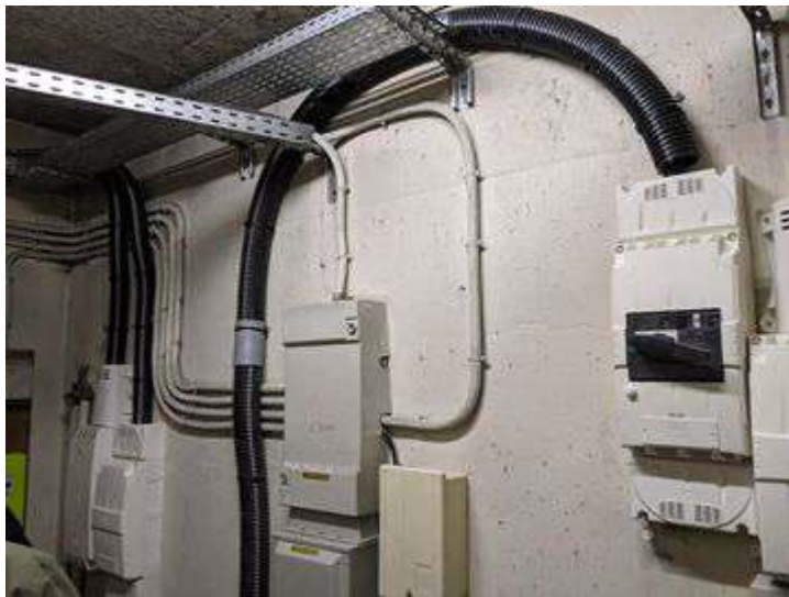
Arrivée d'une colonne électrique
