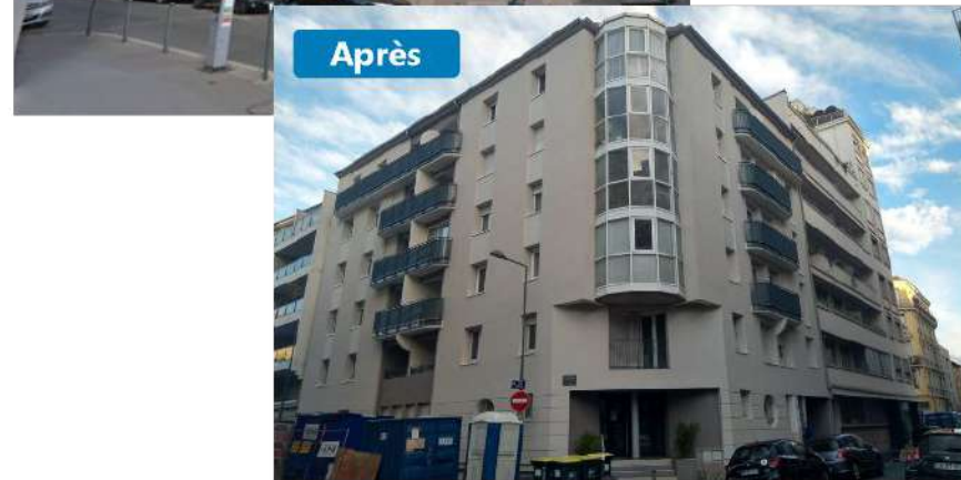
Une rénovation qui répare le bâtiment et améliore la qualité de vie des habitants
