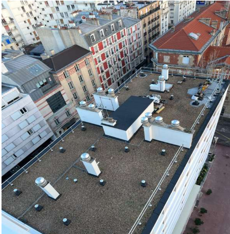
Mise en place de tourelles Hybride VTI et alimentation sur chemin de cable
