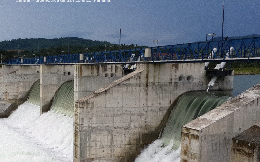
Central Hidroeléctrica de San Lorenzo (Panamá)
