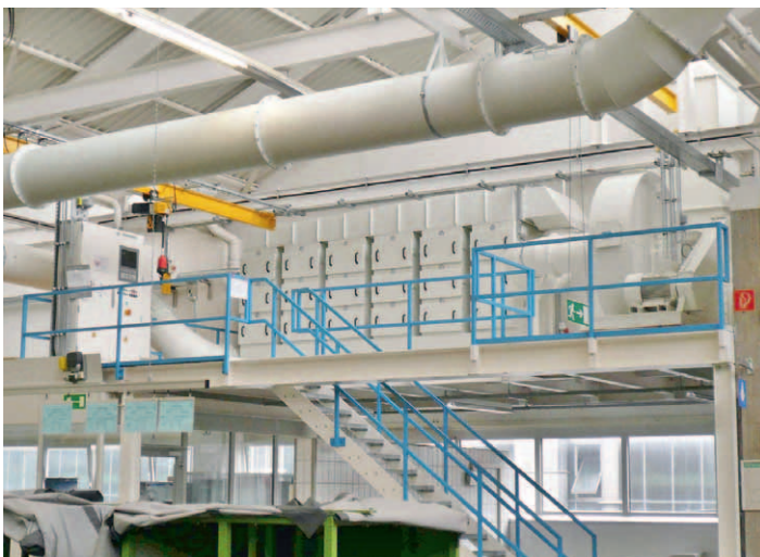
Bild 25 Zentral-Absauganlage
