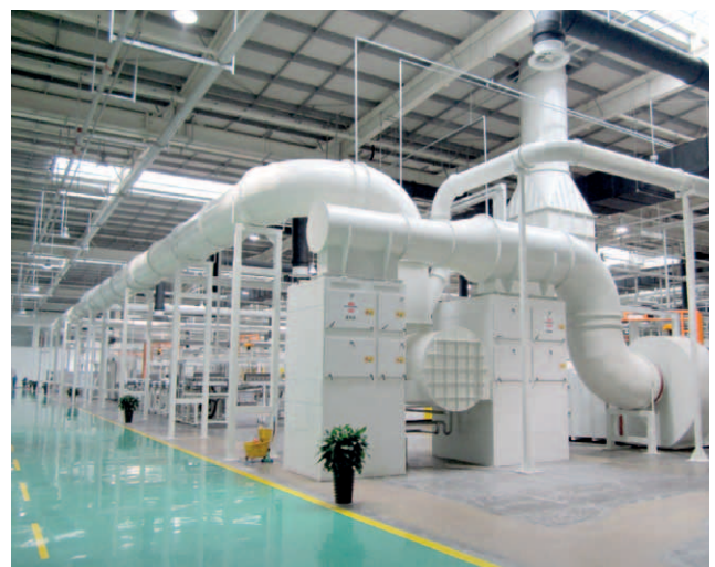
Bild 24 Zentral-Absauganlage
