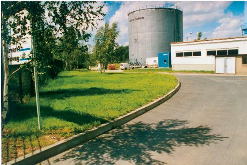
Bildmitte: der 18,5 Meter hohe Leichtöltank mit einem Fassungsvermögen von 5.000 m<sup>3</sup> (Quelle: MSW)
