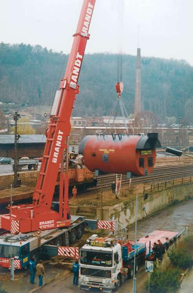
**Verladung des Heizkessels für den Einsatz von HEL (leichtes Heizöl) und Erdgas im April 1992**
