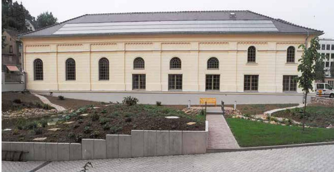
117 Dünnschichtmodule mit einer maximalen Leistung von 4,68 kWp wurden harmonisch in das Ziegeldach integriert. Die Solarzelle ist in der Lage, die Sonnenenergie direkt in elektrische Energie umzuwandeln (photovoltaischer Effekt).
