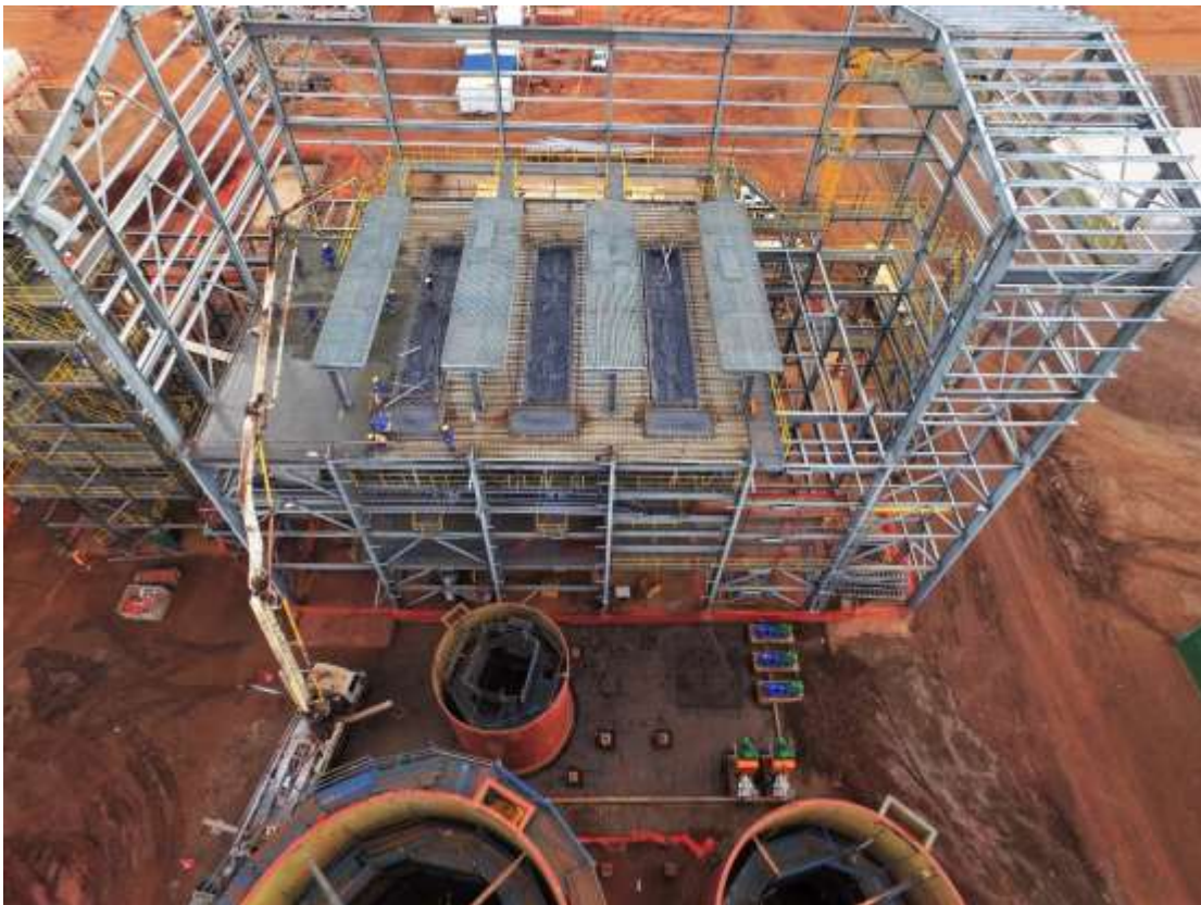
Filtration suspended floor concrete pour
