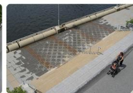
Di fronte alla grande panca in pietra artificiale, la semplice pavimentazione in blocchi di cemento è trattata con un additivo ritardante dato secondo un pattern che si rivela solo quando, dopo la pioggia, l'acqua evapora più lentamente là dove insiste il disegno pavimentale. Nelle foto, un esempio da Peg-Dew Point Landscape design.
