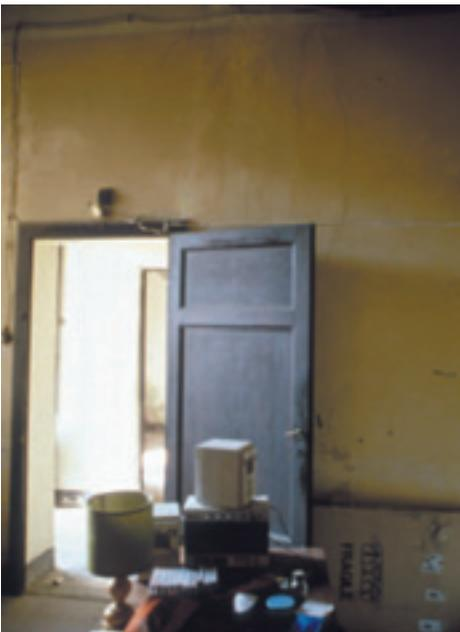
Fig. Cb6, Cb7 Dettaglio di una parete di uno degli ambienti più poveri prima e dopo il restauro. La porta in pioppo coperta da vernice marrone è stata riportata a legno ed è stata realizzata una apertura di forma ellittica per ottenere un effetto di trasparenza tra cucina e soggiorno
