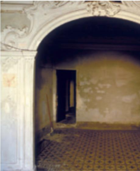
Fig. Aa2, Aa3 L'alcova prima e dopo la scopertura e il restauro delle decorazioni e degli stucchi. Il pavimento ottocentesco in mattonelle di cemento è stato risarcito nelle lacune con materiale riprodotto da una ditta specializzata. La finta tappezzeria sulle pareti appare di epoca posteriore rispetto agli stucchi ottocenteschi
