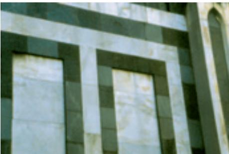
*Fig. 5 Firenze, Duomo, dettaglio del paramento esterno. La bicromia è ottenuta con fasce e riquadri di "Verde di Prato" sul fondo bianco del marmo. Il Verde di Prato è una serpentina (una roccia effusiva basica)*
