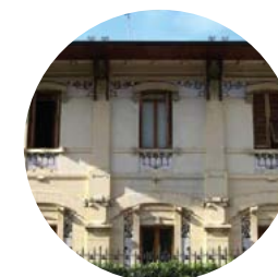
2. Villino Ravazzini via Scipione Amminato
