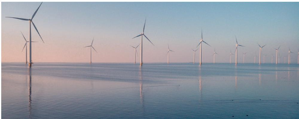
Le vent est variable au long de l'année. L'éolienne tourne entre 75 et 95% du temps, mais pas toujours à pleine puissance. Les pales sont en rotation tant que la vitesse du vent reste comprise entre 3 mètres par seconde et 25 mètres par seconde.
