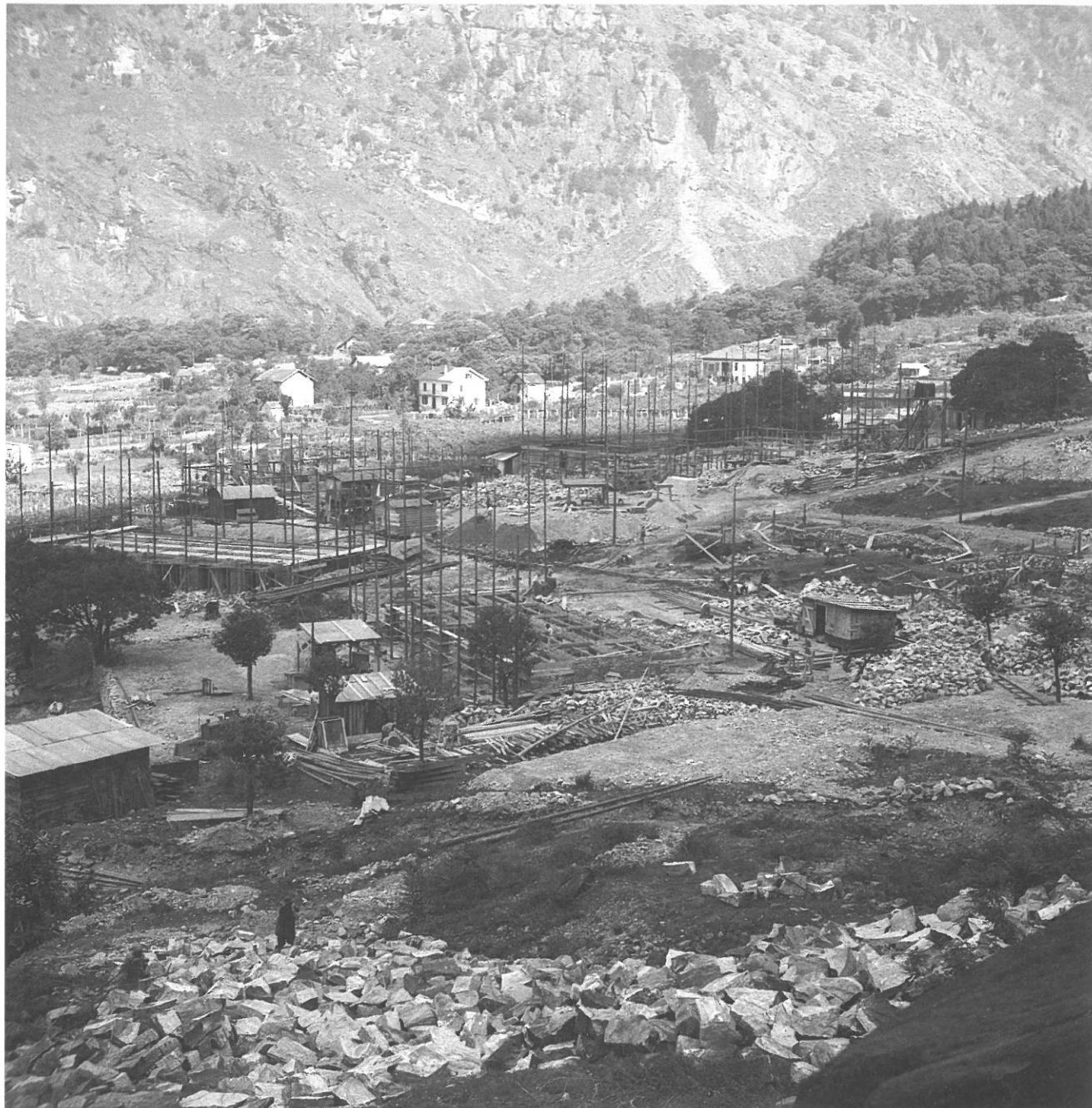
Sopra: Il cantiere nel luglio del 1941, fotografia del fondo dell'architetto Bruno Brunoni. Si notino i blocchi di granito in primo piano per l'esecuzione delle facciate.
