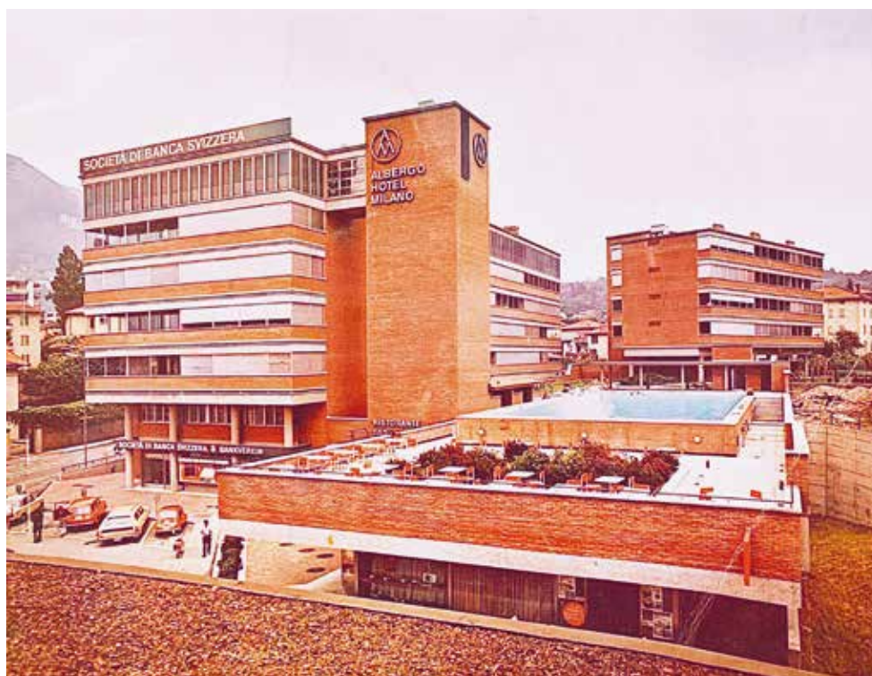
DIE ALBERGO MILANO AUF DER TITELSEITE DER NR. 3/1974 VON „GASTRONOMIE & TOURISME“. EINIGE MONATE NACH IHRER FERTIGSTELLUNG (PRIVATE SAMMLUNG). ZU DER ZEIT EXISTIERT DIE PERGOLA AN DER KOPFSEITE DES SCHWIMMBECKENS UND VOR DEN HOTELTERRASSEN NOCH NICHT. | L'ALBERGO MILANO SUR LA COUVERTURE DU NUMÉRO DE « GASTRONOMIE ET TOURISME », QUELQUES MOIS APRÈS SON INAUGURATION, 1974 (COLLECTION PRIVÉE). À CETTE ÉPOQUE, LA PERGOLA SITUÉE À LA TÊTE DU BASSIN ET DES TERRASSES DE L'HÔTEL N'AVAIENT PAS ENCORE ÉTÉ CONSTRUITE.
