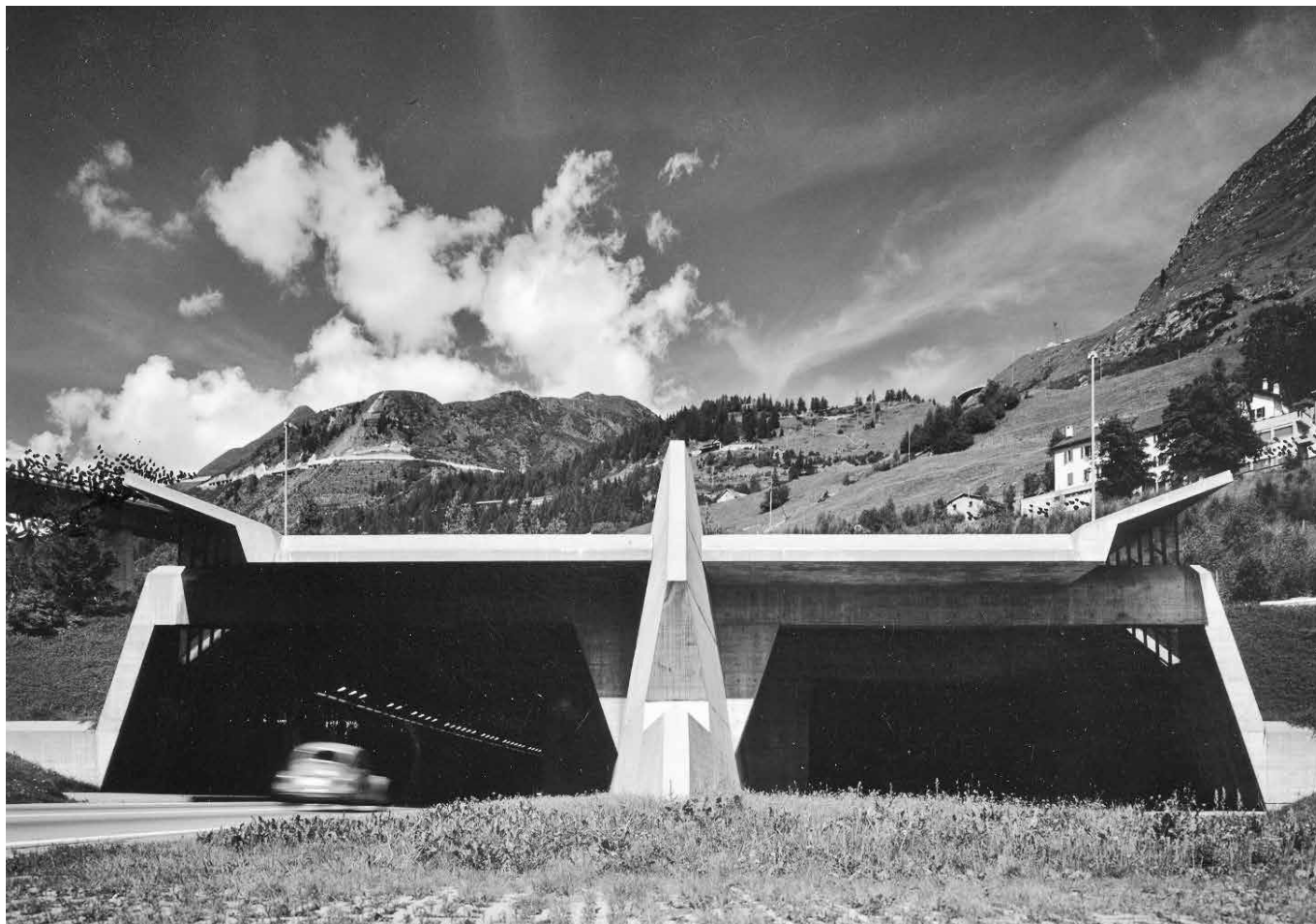
6 Portale sud della galleria del San Gottardo, Airolo. (Archivio del Moderno, Fondo Rino Tami)
