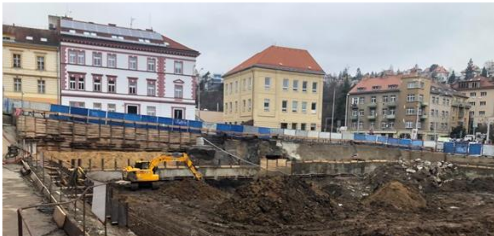
Stav výstavby Residence Laurová ke konci roku 2024
