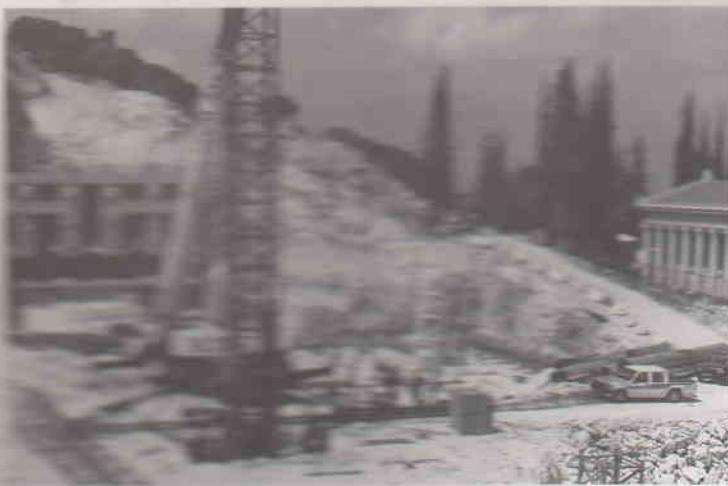
یک برج جراثمال در مرکز بنای دارالتحقيق بروپا شده تا بوسیله آن لوله‌های بلند فولادی نگاهدارنده بالابرهای هیدرولیکی نصب گردد.
