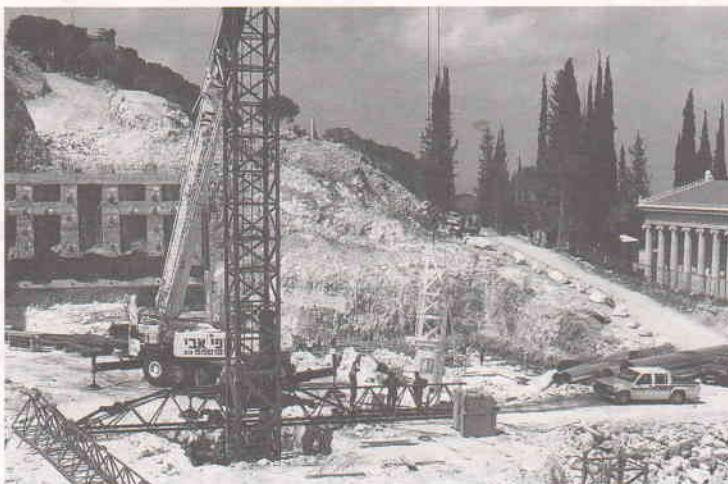
یک برج جراثمال در مرکز بنای دارالتحقيق بر پا شده تا بوسیله آن لوله های بلند فولادی نگاهدارنده بالابرها هیدرولیکی نصب گردد.
