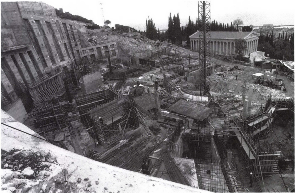
پیشرفت عملیات ساختمانی قوس کوه کرمل دسامبر ۱۹۹۴ فرستنده دائره پروژه کوه کرمل عکاس روحی ورقا
