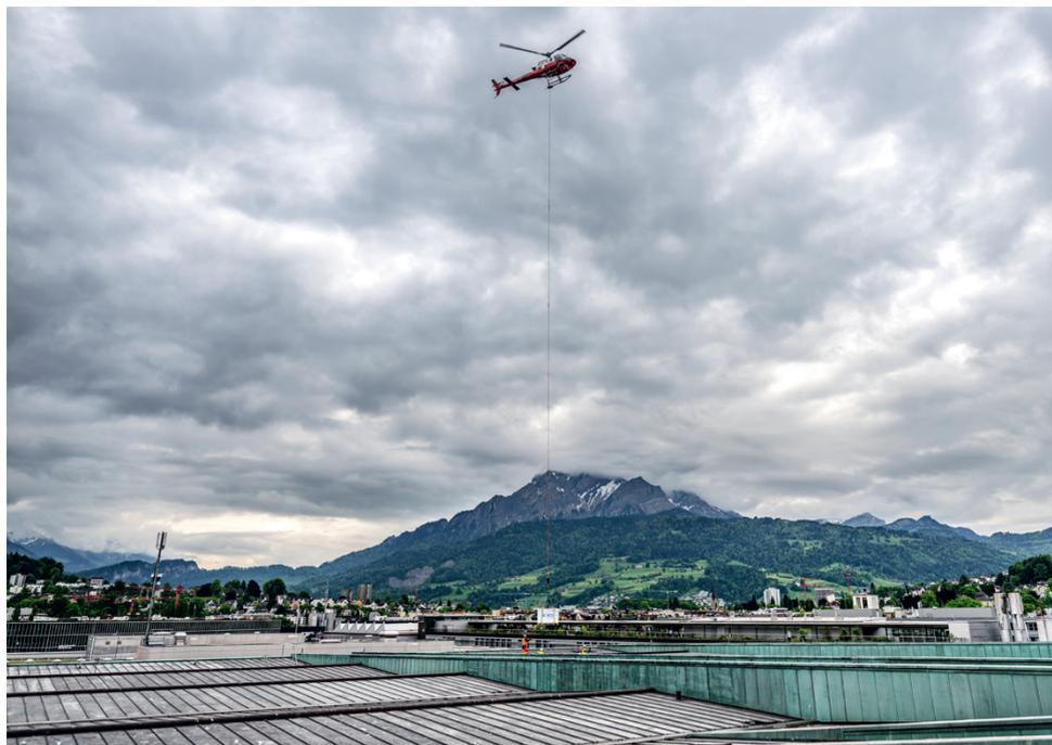
Transportflug der Solarmodule auf das Dach des KKL Luzern
