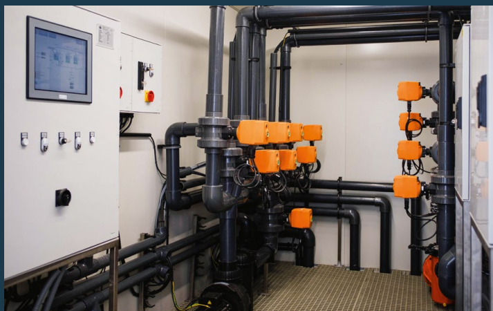
PUMPENSCHRANK MIT TOUCHSCREEN
