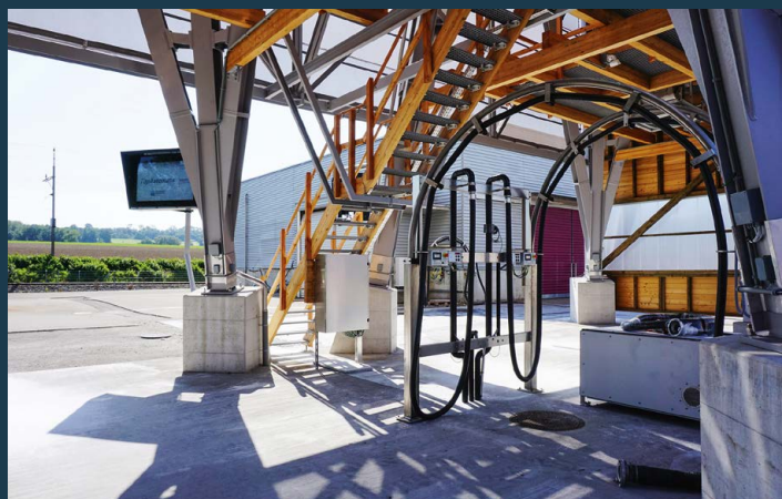
DOMDIER (CH): 2 X 600 M³ SILOS – TOPAUTOMATIK + 2 BRINE EXTRACTION POINTS
