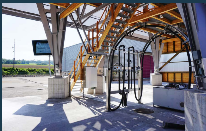
DOMDIER (CH), 2 SILO DA 600M 3 TOPAUTOMATIK + 2 PUNTI EROGAZIONE SALAMOIA
