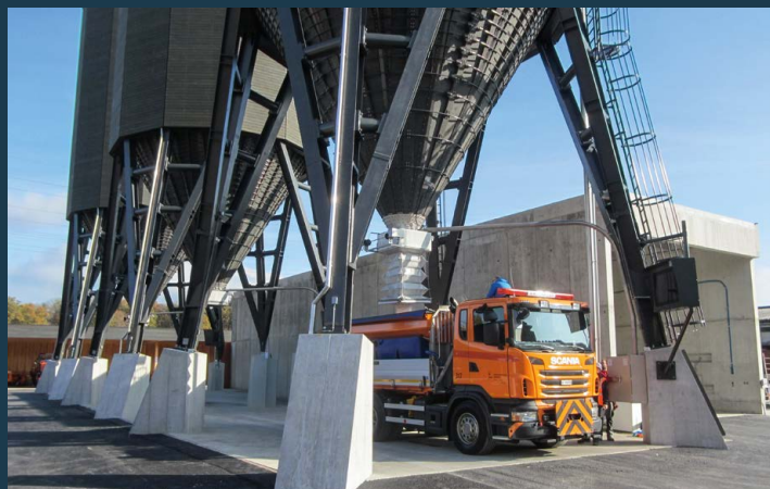
BERNA (CH), 3 SILO DA 900M 3 TOPAUTOMATIK
