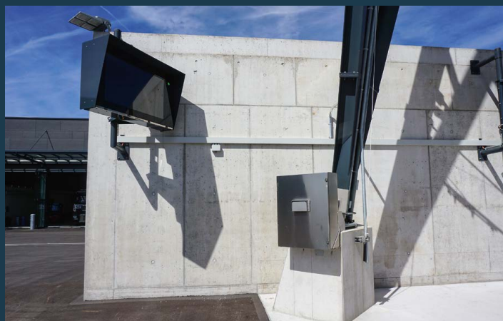
MÜLLHEIM (CH), 2 SILO DA 400M 3 TOPAUTOMATIK
