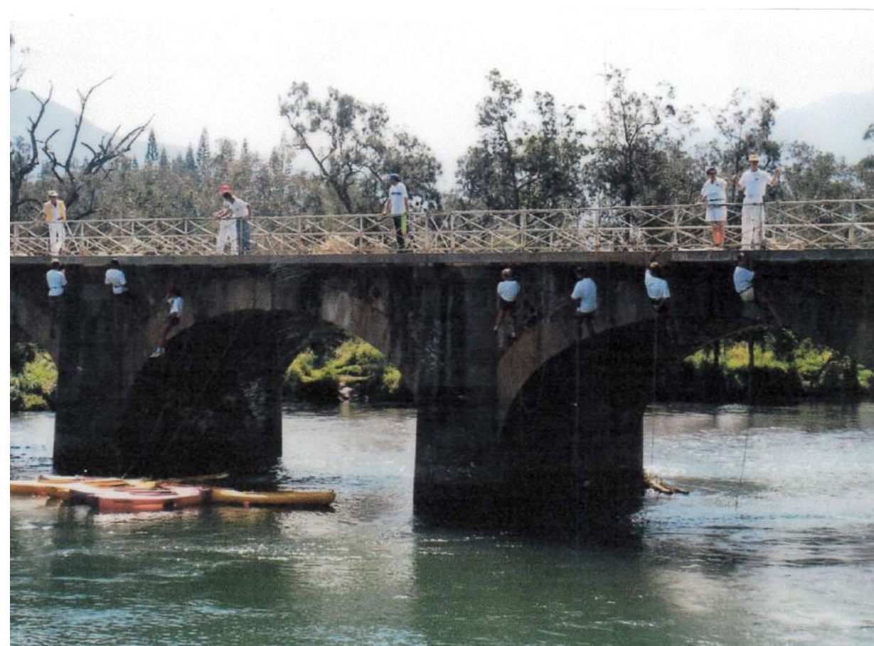
L'escalade du pont de la Dumbéa en 1996
