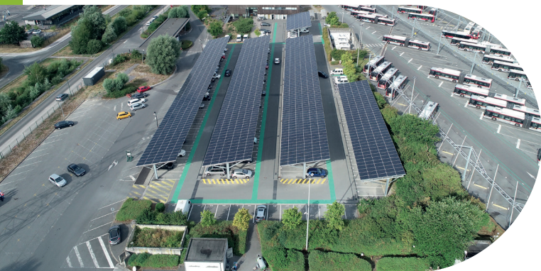
Panneaux photovoltaïques dépôt de bus de Sequedin
