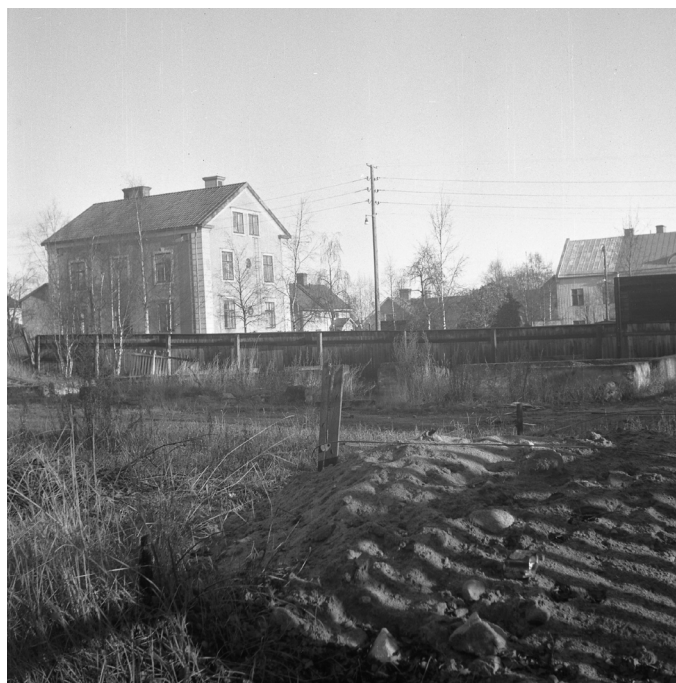
Grunden till Norrskensflammans nedbrunna fastighet. Fotograf: Helmer Widlund, 1940. Källa: Luleå stadsarkiv.
