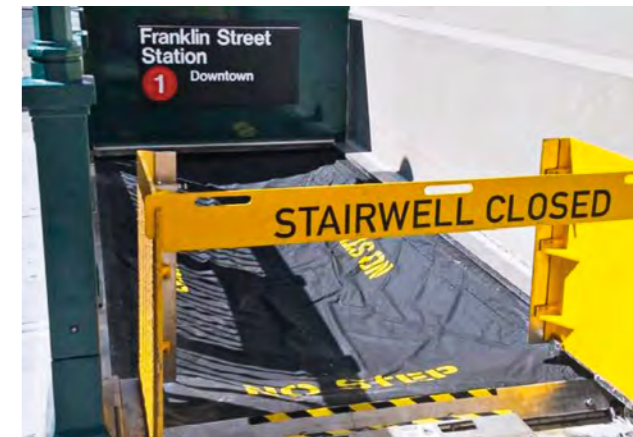
← Portes flexibles et étanches à l'entrée du métro de New York, États-Unis.
